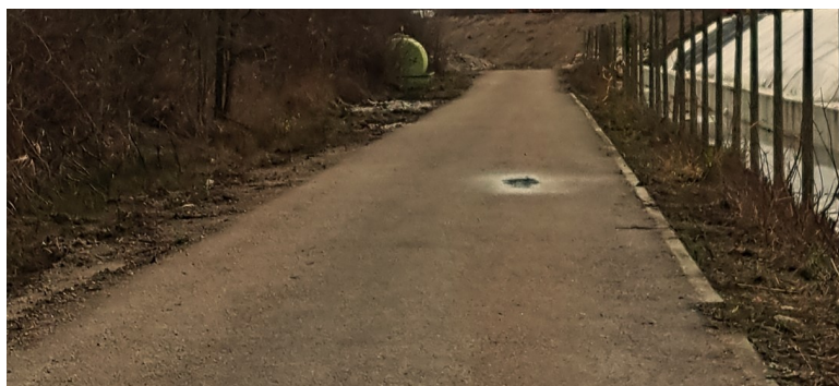
Pista al confine con cantiere parcheggio TIR
