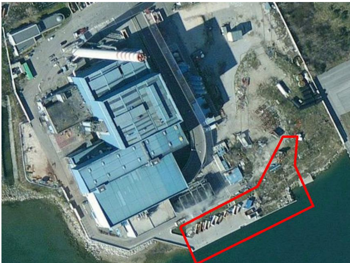
FIG. 4.8.2.b - Vista aerea dell'area destinata a sede definitiva evidenziata in rosso.
