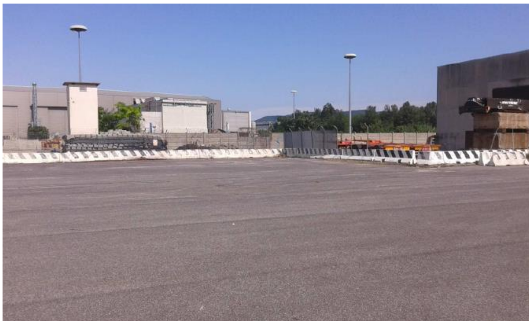
FIG. 4.8.2.c - Parte del piazzale asfaltato destinato alla sede operativa.
