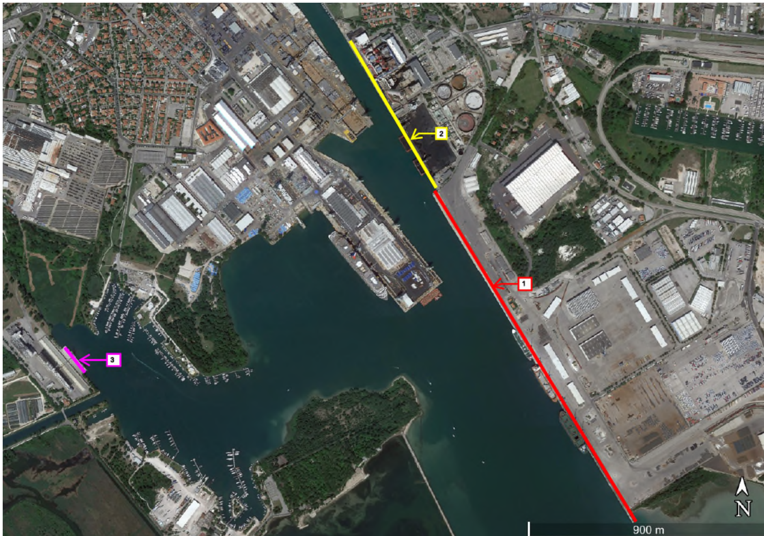
Fig. 0.1 – Vista aerea dell’area del Porto di Monfalcone con evidenziate le banchine utilizzate per il traffico navi commerciali in ambito AdSP MAO.
