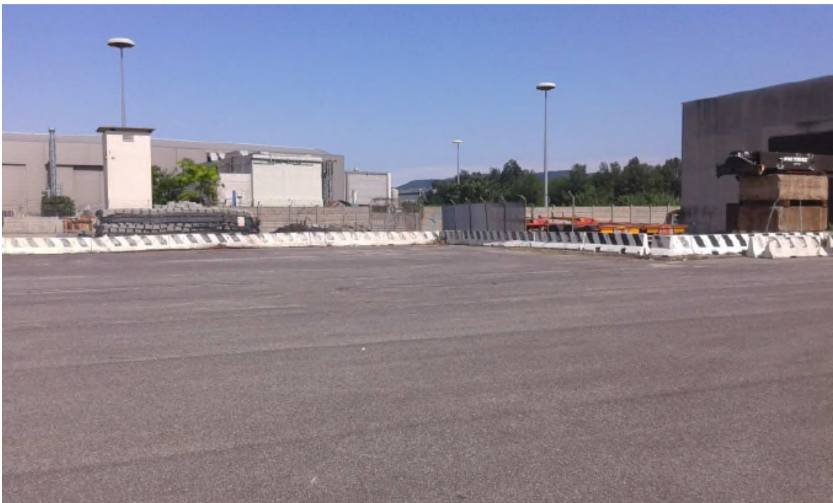
Foto 4.8.c. - Parte del piazzale asfaltato destinato alla sede operativa.
