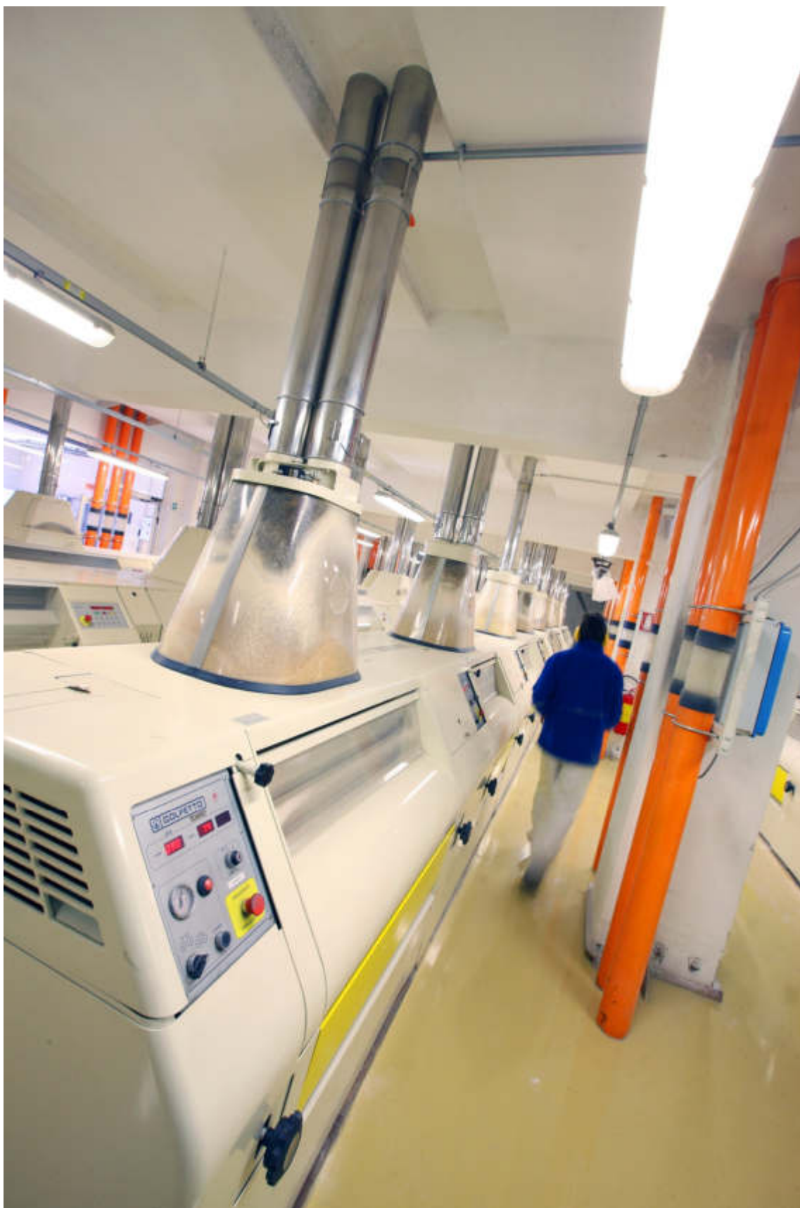
Porto di Trieste, particolare degli interni del magazzino Silocaf. AdSP MAO.
