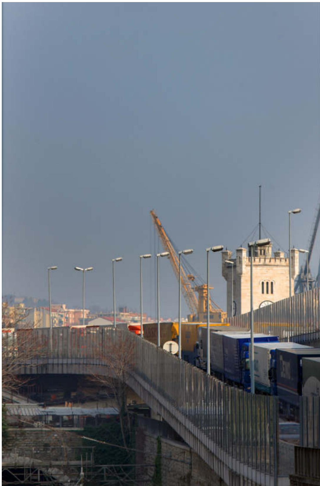
Tratto della Grande Viabilità Triestina e Torre del Lloyd. Foto archivio AdSP MAO.
